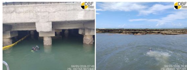
Figura 5. Inspeções subaquáticas realizadas em Maio/2026. Foto: DBF Planejamento e Consultoria.
