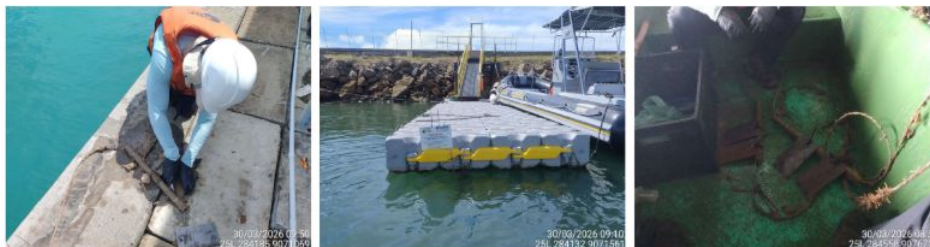
Figura 3. Registros da remoção, instalação de estrutura, substituição e raspagem de placas durante a campanha realizada. Foto: DBF Planejamento e Consultoria.
